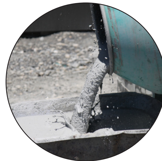
Chape incorporée Slurry
