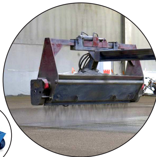
Epandage mécanique Mechanical spreading
